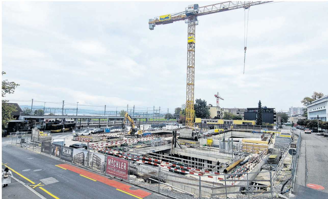
Bald wird nicht nur nach unten, sondern auch nach oben gearbeitet: So präsentiert sich die oberirdische Baustelle direkt aus dem Architekturbüro der 720° Architekten AG über die Bahnhofstrasse und die Poststrasse in Pfäffikon hinweg.
